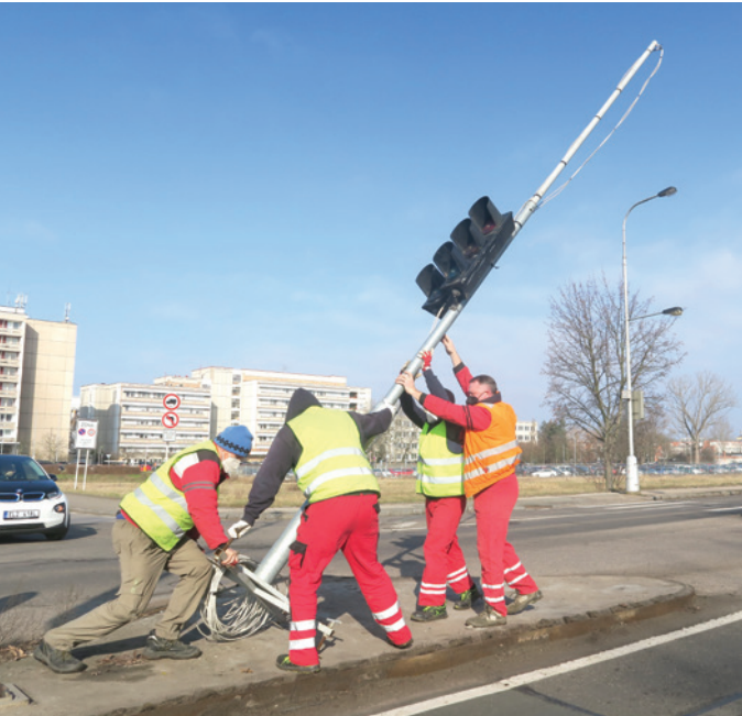
První březnový den se ve Zborovské ulici na křižovatce do fakultní nemocnice objevily semaforey, které mají pomoci zlepšit dopravní situaci. Ta je zde nyní intenzivnější, protože tudy projíždějí auta do nemocnice i nedalekého odběrového centra covid-19 a po zřízení očkovačích centra doprava ještě zhoustne. // Foto: Michal Komárek
